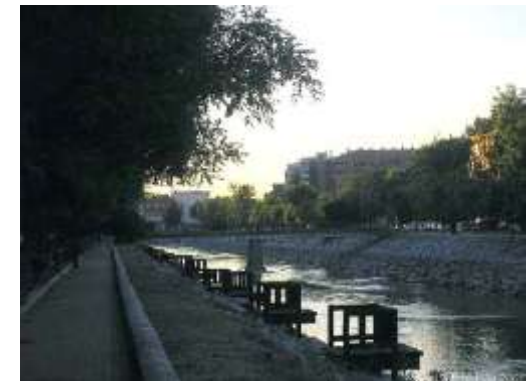
ADECUADO Zona de Río con andador y mobiliario urbano haciéndolo más transitable.
